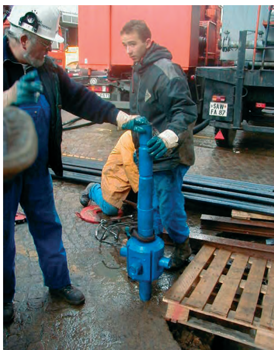
Bild 1: Perforationsdüsenkopf
