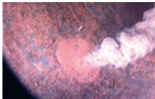
Bild 2: Perforationsloch mit Materialeintrieb
