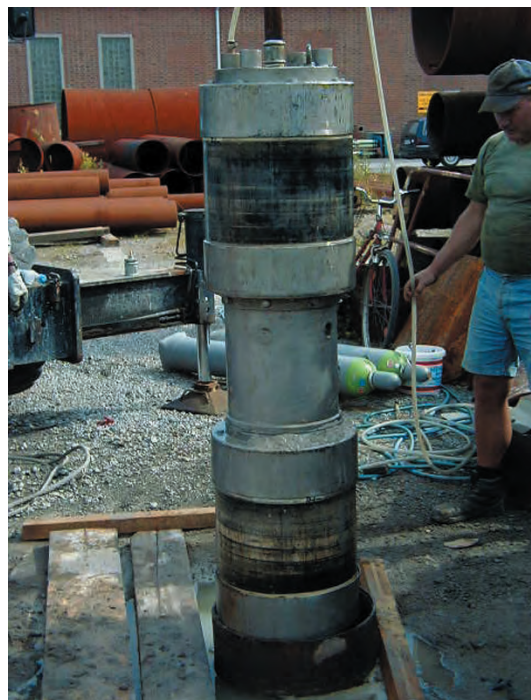
Bild 3: Einfädeln des Doppelpackers in das Brunnenmantelrohrsystem 473 mm Ø
