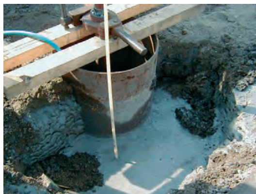
Bild 9: Bis GOK aufgestiegene Ton-Zement-Suspension
