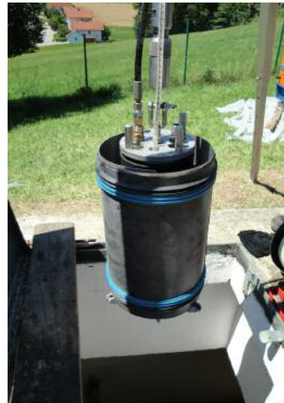
Abb. 7 Die Innenrohrmanschette zusammen mit dem Packer vor dem Einbau
