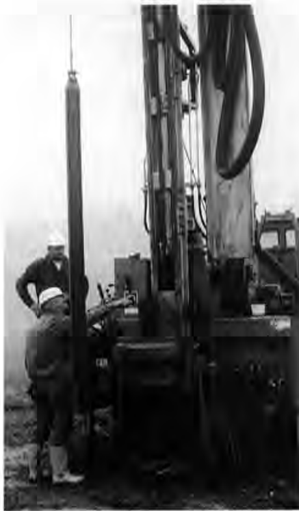
4 Freifallgewicht 250 kg, für Rammkernbohrung
