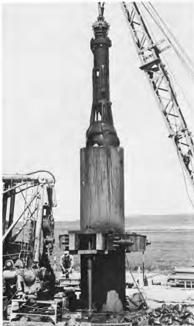
5 Einpressen der Verrohrung ( \varnothing 1220 mm) und Herausfordern des Bohrgutes mit dem Baade-Greifer ( \varnothing 1 m)
