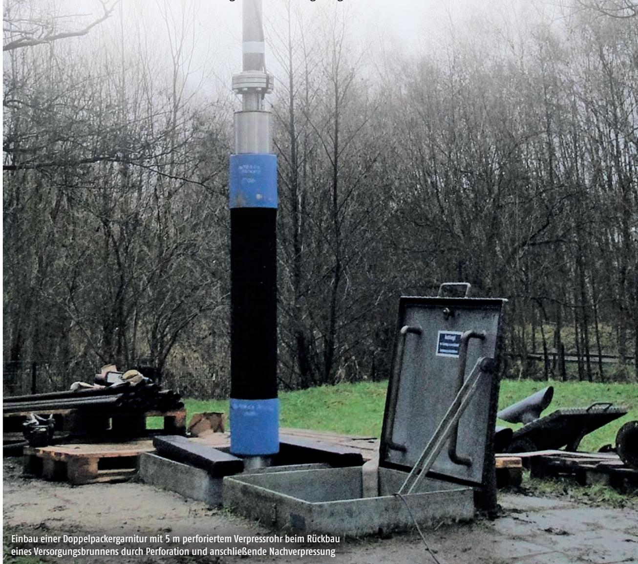
Einbau einer Doppelpackergarnitur mit 5 m perforiertem Verpressrohr beim Rückbau eines Versorgungsbrunnens durch Perforation und anschließende Nachverpressung
