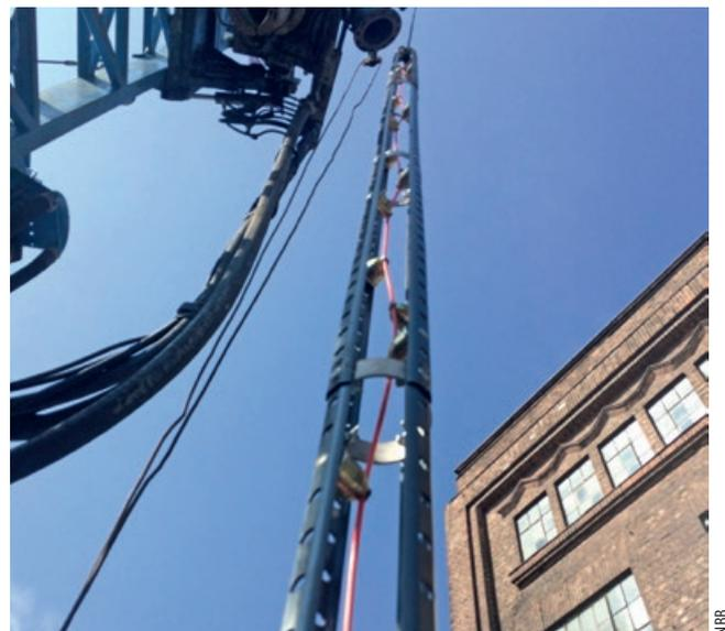
Abb. 5 – Einbau eines Korbes mit versetzt angeordneten Hohlladungen
