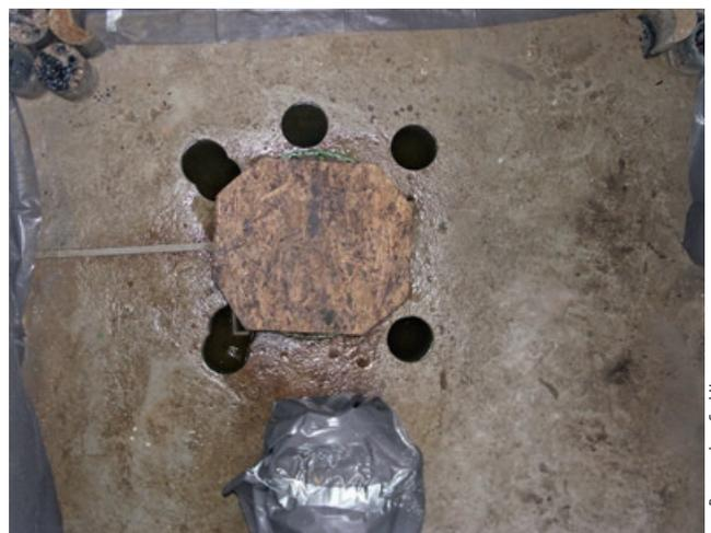
Abb. 2 – Lage der Verpressbohrungen um den Brunnenkopf
